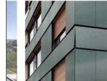
Bau des Monats 02/2023 Oberwilerstrasse Salathé Architekten haben die Fassade eines Mehrfamilienhauses vom und beim Zoo Basel saniert. Das 1962 erbaute Haus zeigt sich nun stadtsseitig mit einem sinnlich wirkenden Kleid aus dunkelgrünen Photovoltaik-Paneelen – in nur zwei Formaten! – und Holzrollläden.
