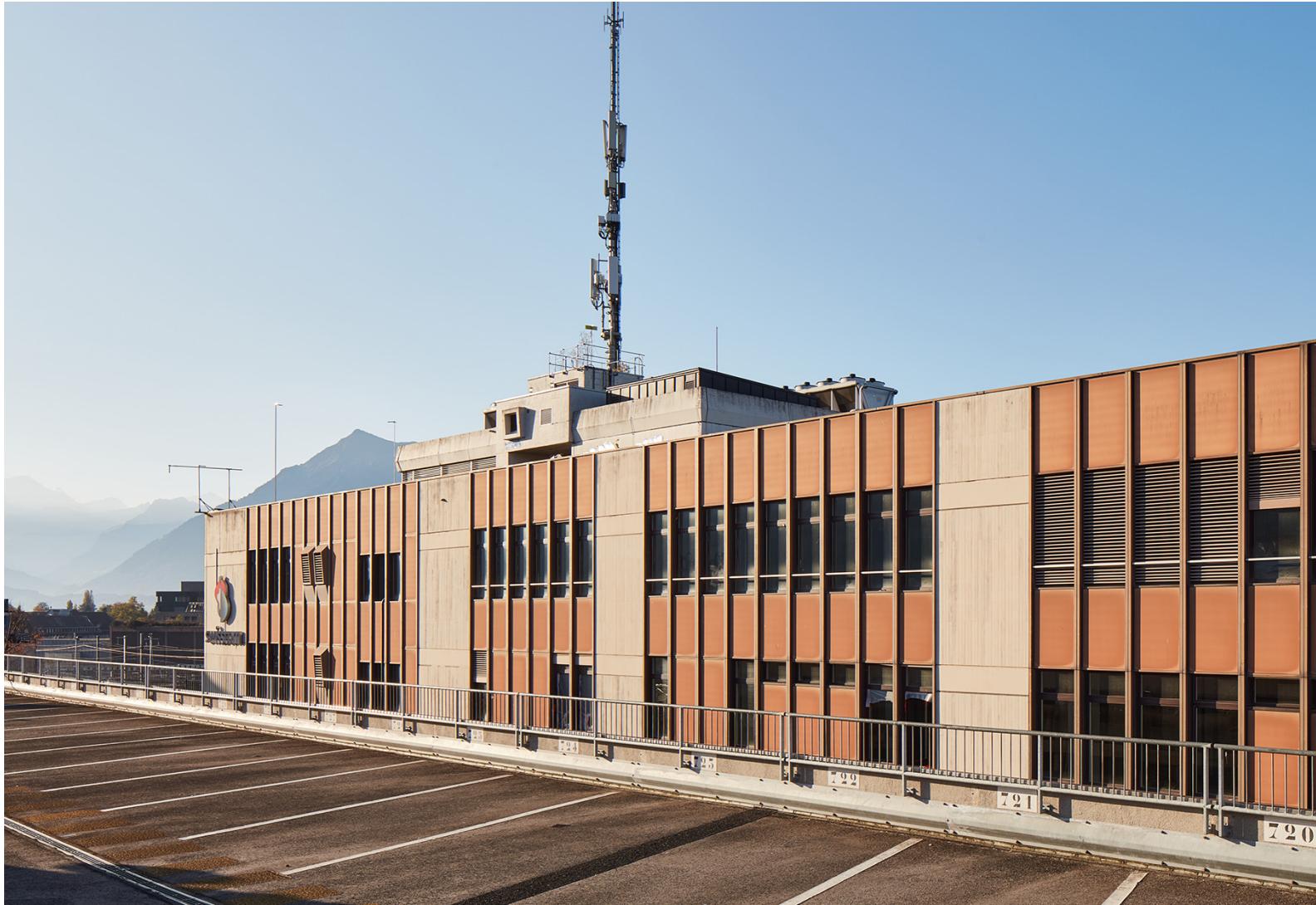
Umbau ehemaliges Swisscom-Gebäude, Thun BHSF Architektur & Städtebau
