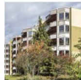
Bau des Monats 03-04/2024 Lindenberg
