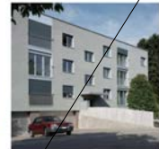
Bau des Monats 07/2022 Eichweid
