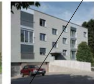
Bau des Monats 07/2022 Eichweid
