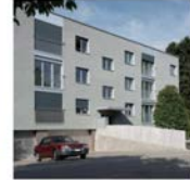
Bau des Monats 07/2022 Eichweid
