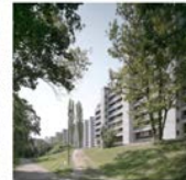
Bau des Monats 11/2022 Teili B & C Melli Peter Architekten realisieren die energetische Sanierung der Teili Hochhäuser Teil B und C in Aarau. Beim Komplettersatz der Bauteile der Fassaden sind dabei kaum Unterschiede zum Originaldruck zu erkennen.
