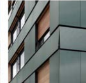
Bau des Monats 02/2023 Oberwilerstrasse Salathé Architekten haben die Fassade eines Mehrfamilienhauses vom und beim Zoo Basel saniert. Das 1962 erbaute Haus zeigt sich nun stadtseitig mit einem sinnlich wirkenden Kleid aus dunkelgrünen Photovoltaik-Paneelen – in nur zwei Formaten! – und Holzrollläden.
