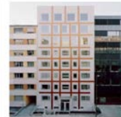
Bau des Monats 10/2022 Avenue de Sécheron Burrous Nussbaumer Architectes haben im Genfer Stadtteil Sécheron ein fünfgeschossiges Wohnhaus von 1958 um drei Etagen aufgestockt und die Gebäudehülle saniert. Stadtreparatur, Erweiterung der Wohnungstypologien und eine raffinierte Erdbebenertüchtigung zeichnen das Projekt aus.
