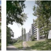
Bau des Monats 11/2022 Telli B & C
